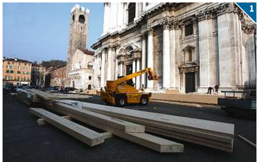
L'ALLESTIMENTO. Nelle scorse ore in piazza Paolo VI gli operai si sono messi al lavoro per allestire il palco dal quale Benedetto XVI celebrerà la messa e reciterà l'Angelus. Per il pontefice si sta cercando di preparare un centro storico bello e accogliente. Tant'è che addirittura stati fatti sloggiare un paio di cantieri aperti.
