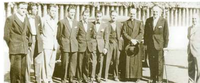
La fotografia. Montini con Folonari e gli operai che costruirono la chiesa
